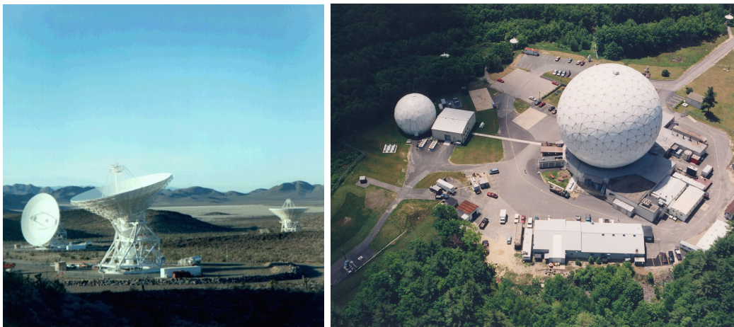
FIGURE 1.14 – Sites américains les plus importants dans le cadre de l'observation de débris spatiaux. À gauche : le réseau de radars DSN du site de Goldstone en Californie, capables de détecter des objets dès 2 mm de diamètre à une altitude inférieure à 1 000 km. À droite : l'Haystack (LRIR) et l'HAX sur le site de Lexington dans le Massachusetts, dont la capacité d'observation pour les débris spatiaux, en association avec le Millston Hill, est de 5 cm à une altitude de 900 km (© NASA).
